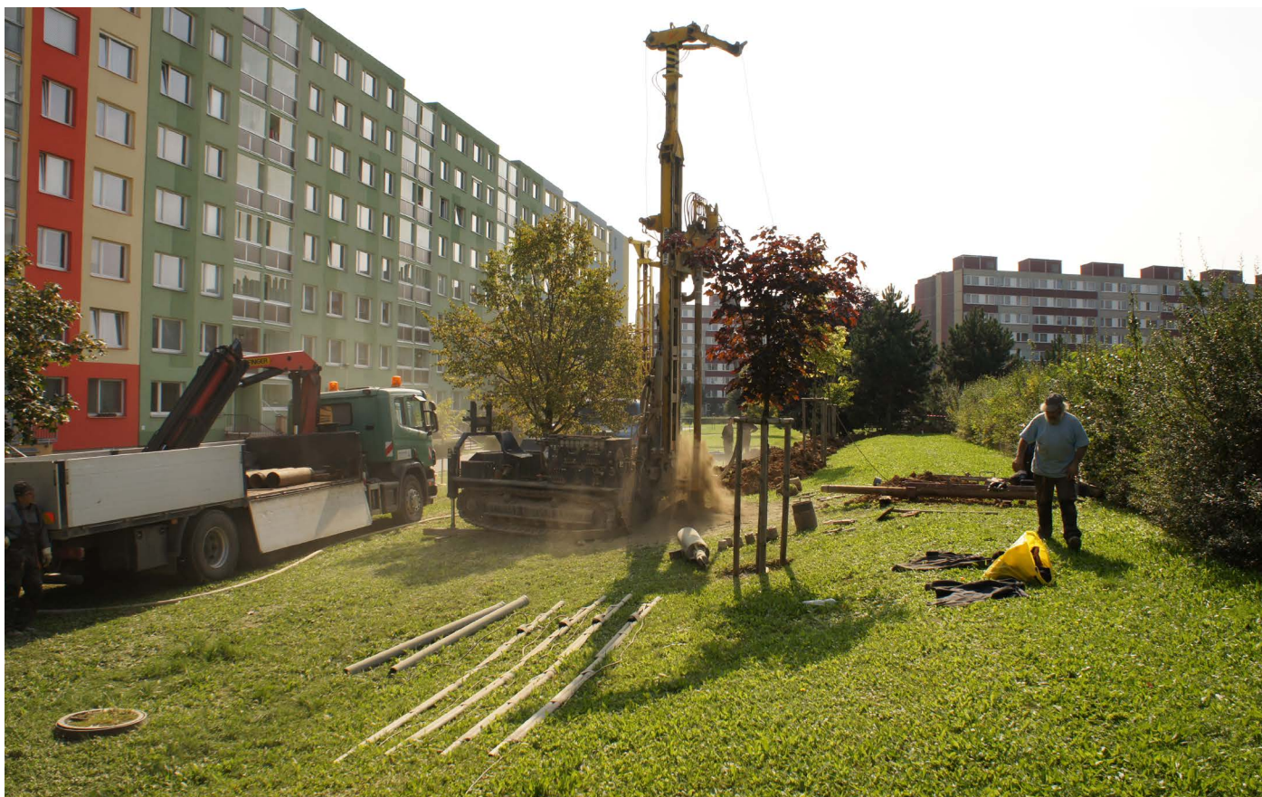
Obr. 3 – vrtné práce pro vertikální anodu v intravilánu Prahy v sušších půdách
