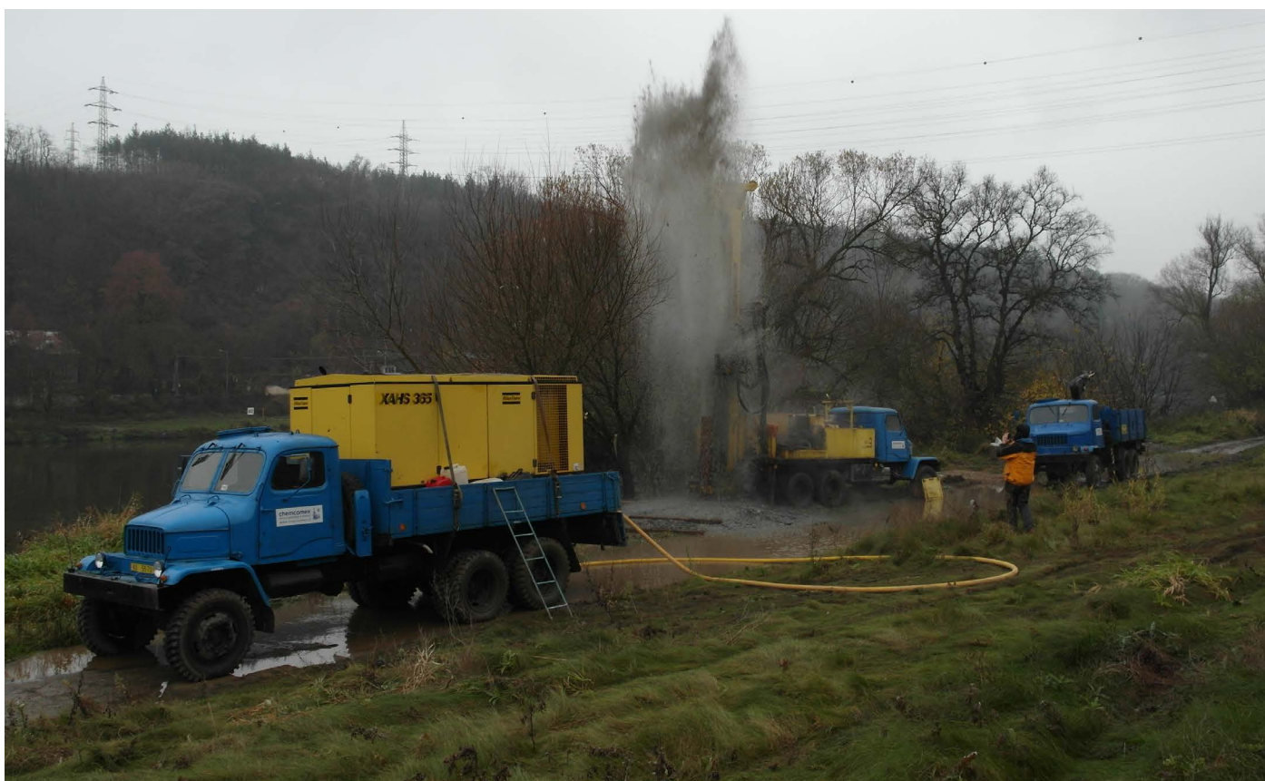
Obr. 4 – vrtné práce pro vertikální anodu na okraji Prahy u Vltavy – mokré štěrkové lavice
