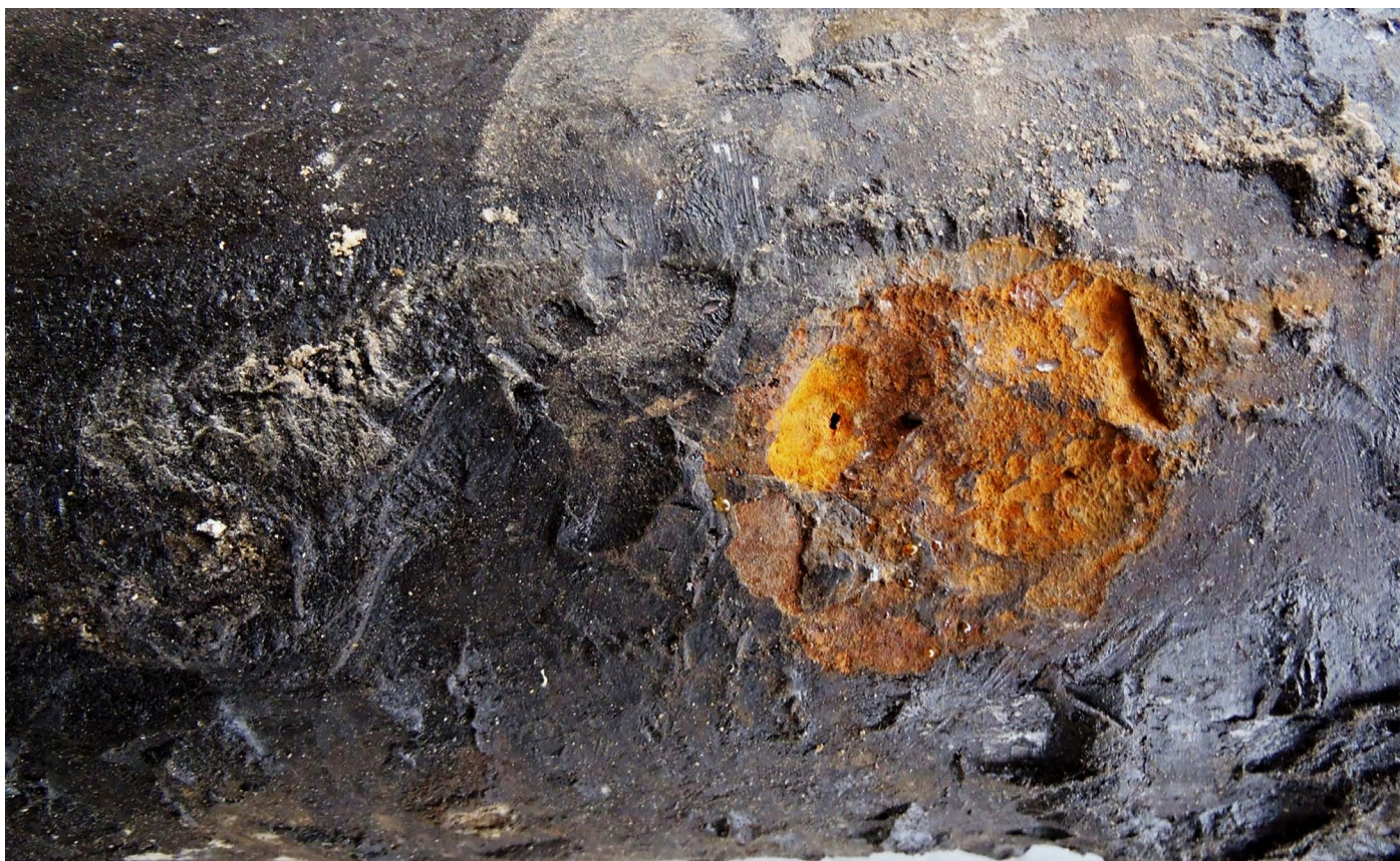
Obr. 1 – koroze bludnými proudy s APKO (korozní napadení je již pasivované ochranným proudem)
